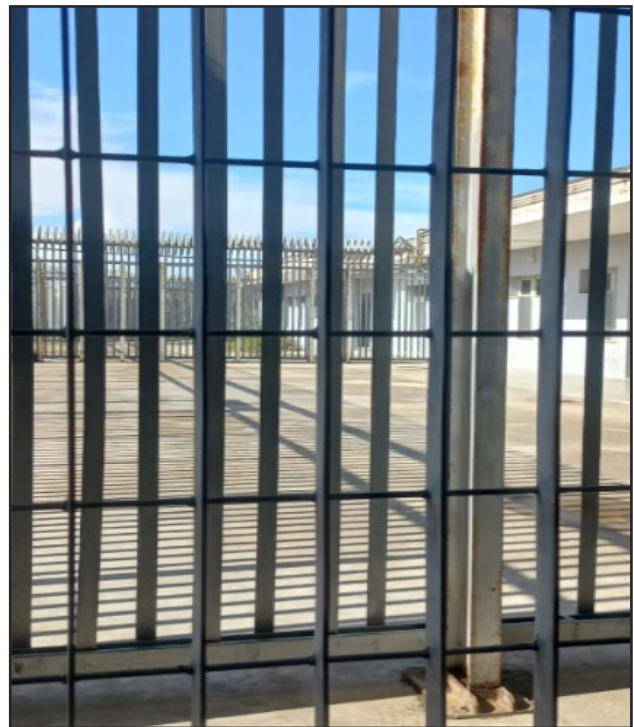
Modulo detentivo - Sezione femminile CPR Ponte Galeria Fonte: CILD
